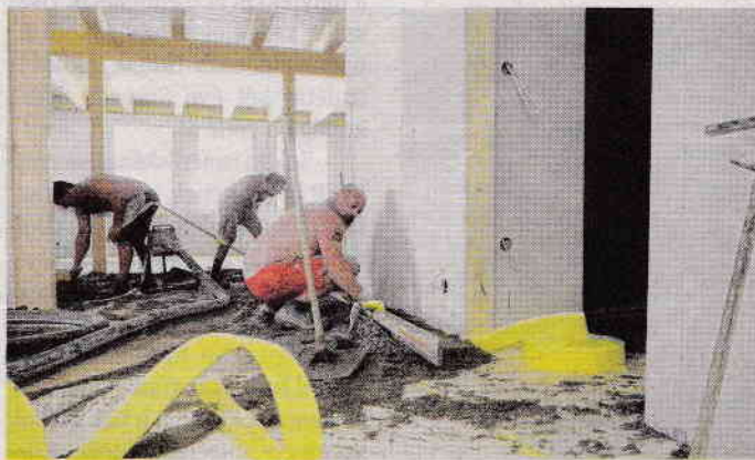
Jelenleg a múzeumépület belső munkálatait végzik.
